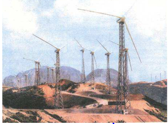
طواحين هوائية لإنتاج الكهرباء
