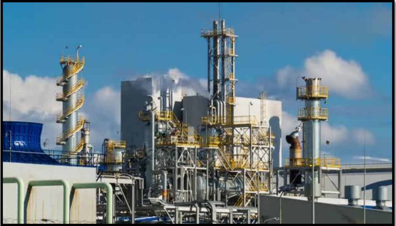
Une unité de production de l'industrie chimique : production d'acide nitrique
