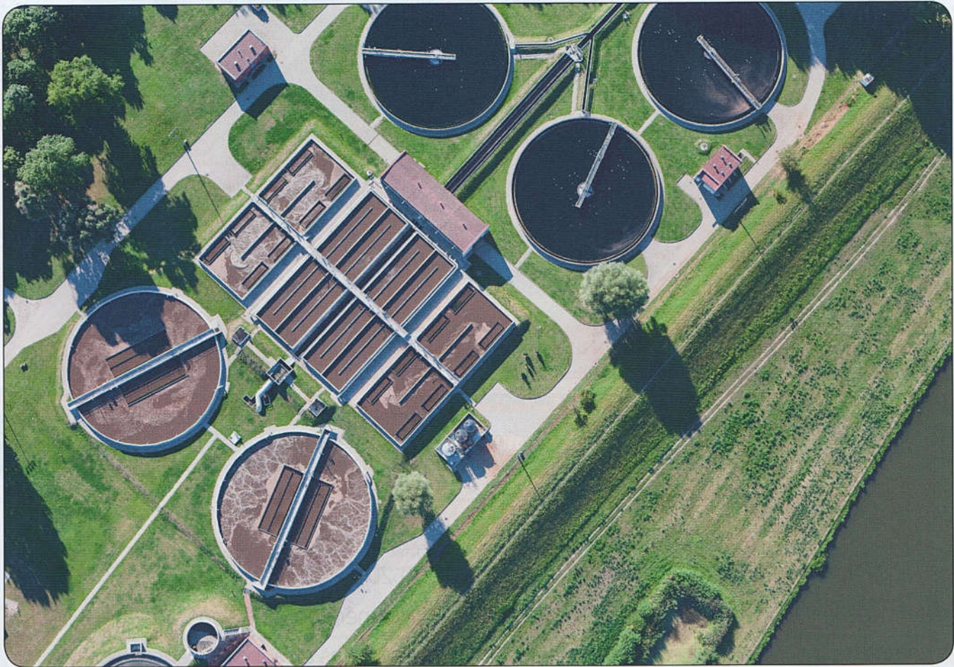
Doc 1 : Station de traitement des eaux usées.
