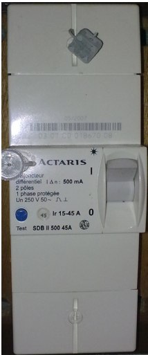
فاصل رئيسي Disjoncteur
